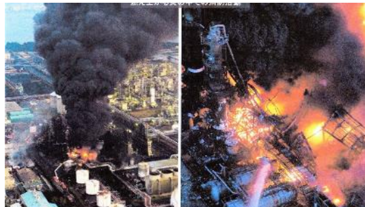
2012.04_レゾルシン設備爆発火災 (山口県 岩国大竹地区)
