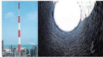
狭小空間点検（ボイラー煙突等）
