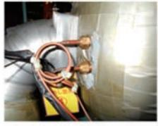
図 漏えい箇所 (ナット部のみ露出)
