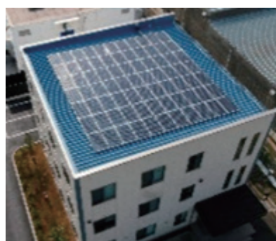
図6 太陽光パネル
