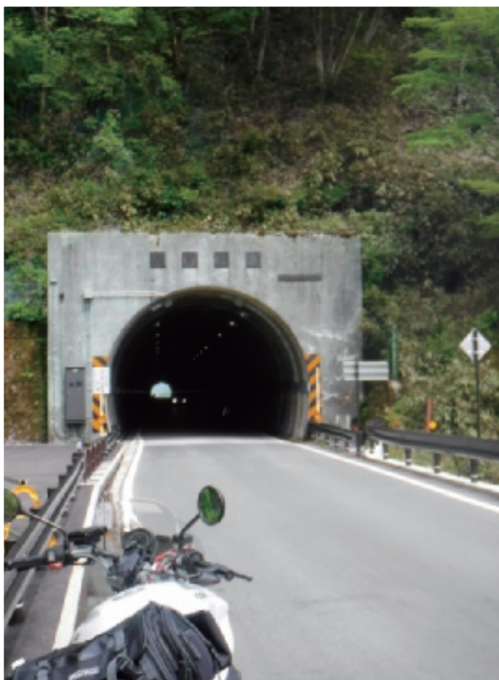
⑥ 金時隧道
