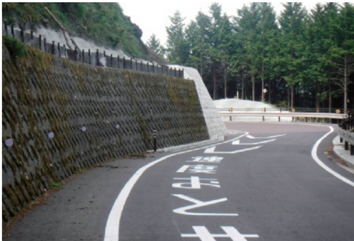
⑤ 拡幅された路面(新旧の擁壁)
