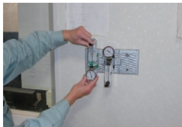
図11 配管末端器点検状況
