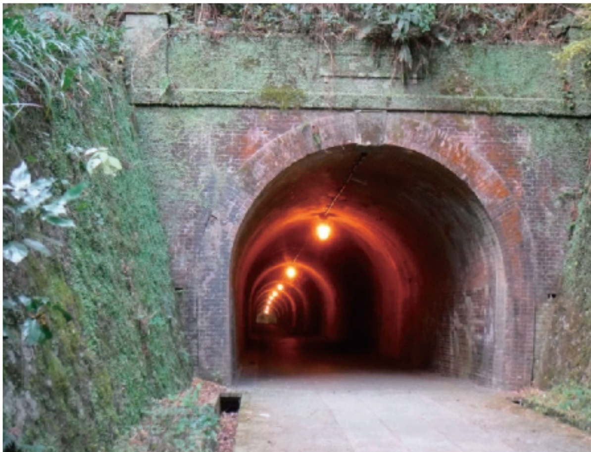
② 宇津ノ谷トンネル明治
