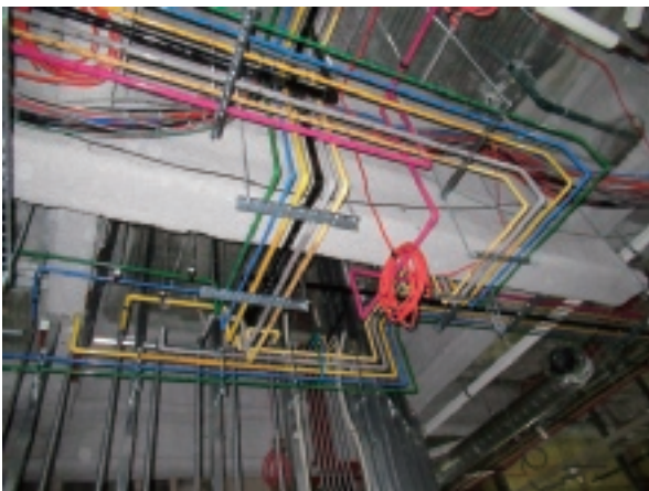
図7 実際の配管施工の様子
