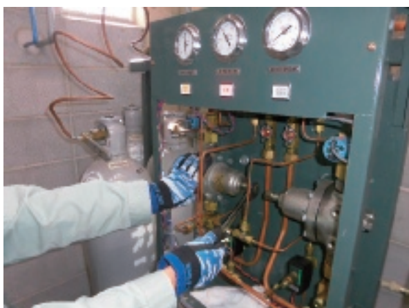
図10 窒素供給装置点検状況
