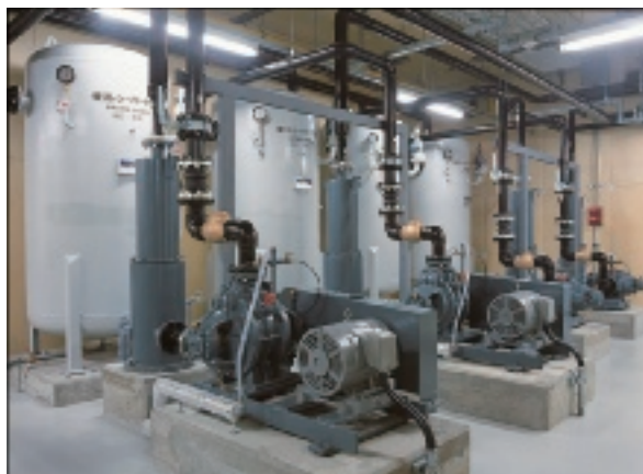
図2 吸引供給設備例
